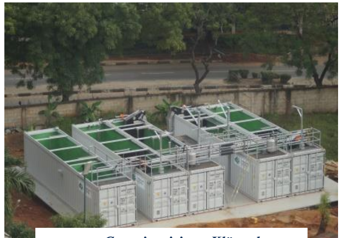
Containerisierte Kläranlage
